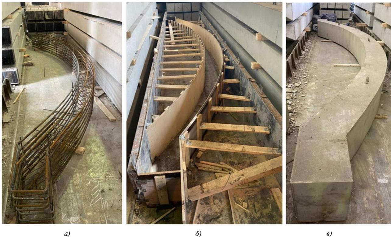
Рис. 3. Визуализация процесса создания железобетонной конструкции:
