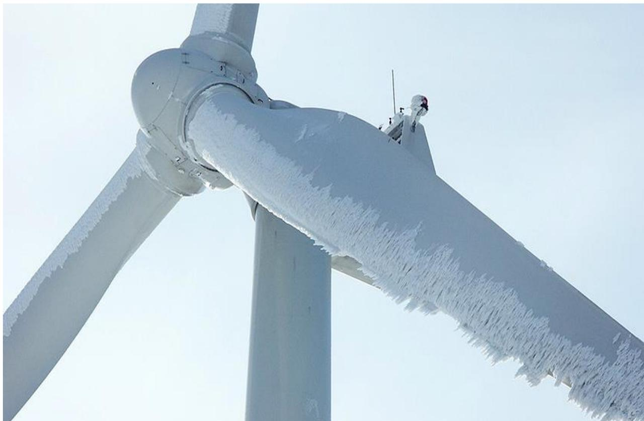
Рис. 1. Пример обледенения лопасти ветрогенератора
