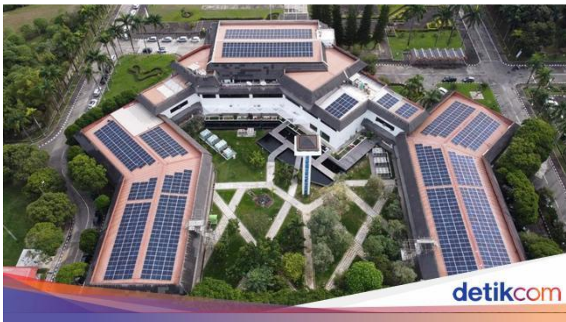
Рис. 3. Размещение солнечной электростанции на крыше здания. Индонезия, г. Бонтанг, Восточный Калимантан 3
