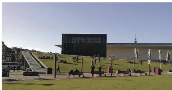
Рис. 11. Газоны эксплуатируемой кровли ТЦ на музейной площади Амстердама (2013 г.) [8]
