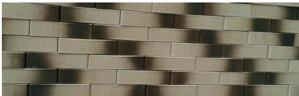
Рис. 10. Декоративная кладка кирпича (ангобные составы Б-2, К-4 и Г-1)
