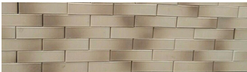
Рис. 9. Декоративная кладка кирпича с применением эффекта деграде (ангобные составы Б-2, К-4)
