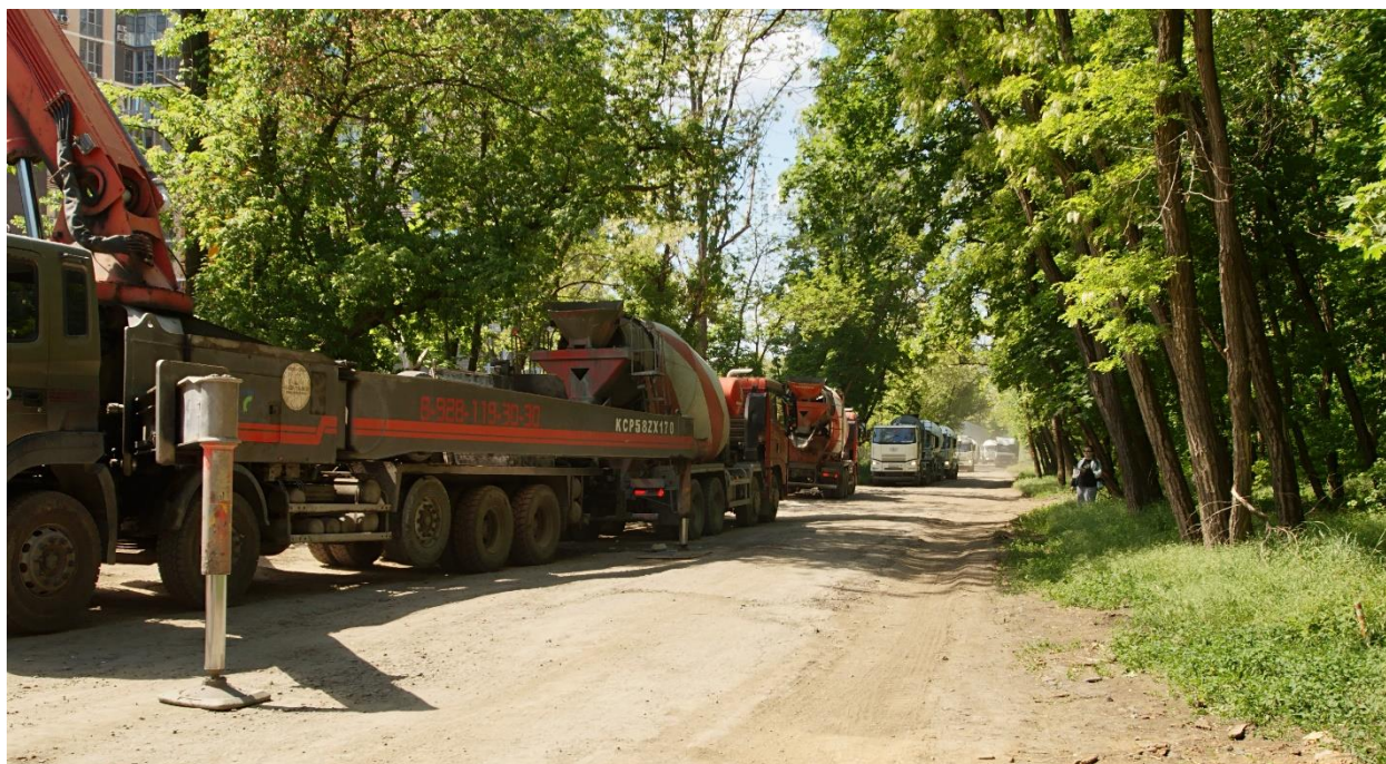
Рис. 5. Рабочая площадка АБН 2
