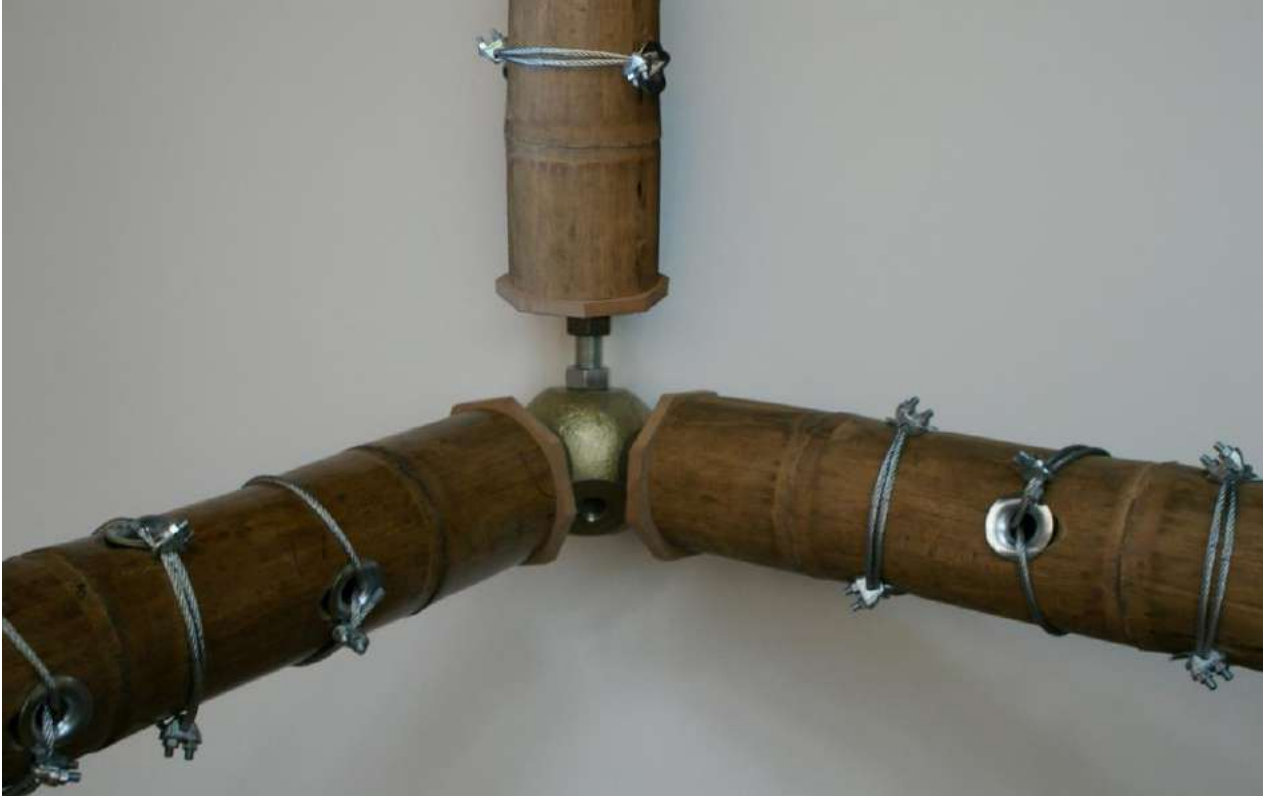
Рис. 2. Применение соединения для пространственной конструкции
