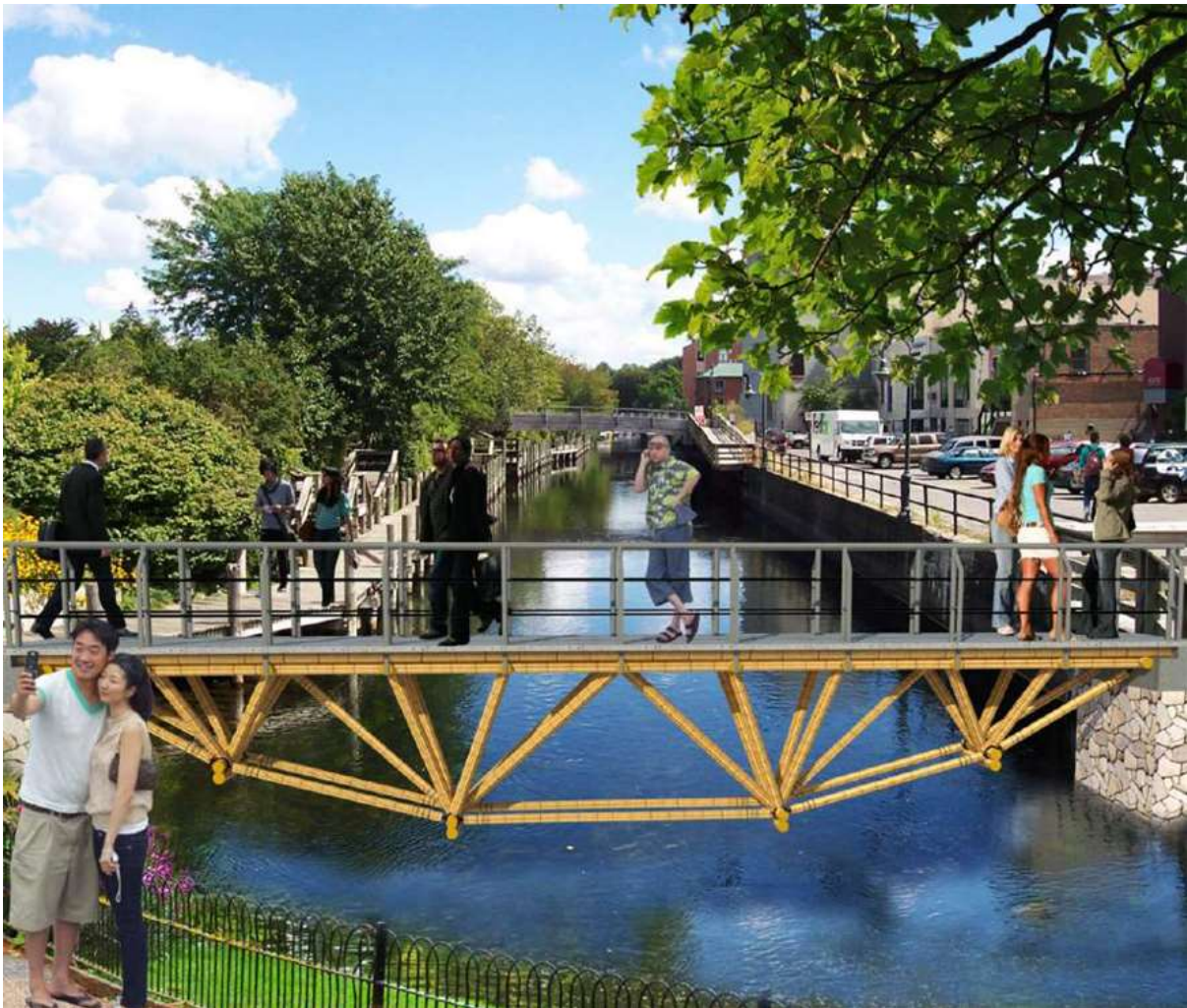
Рис. 4. Пример простой конструкции моста с пролетом 10 метров
