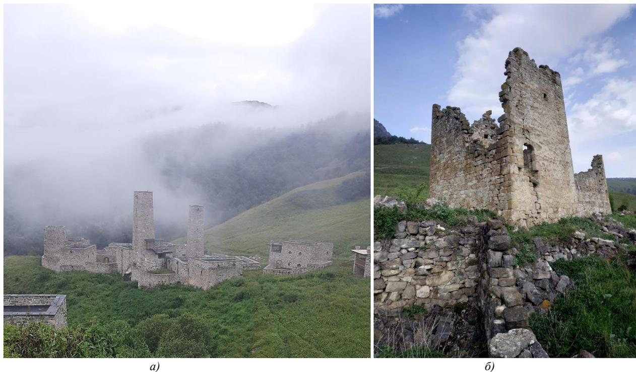
Рис. 1. *а* — отреставрированный архитектурный башенный комплекс «Бишт»; *б* — башенный комплекс «Герете» («Герате») не подвергавшийся перестройке и реставрации
