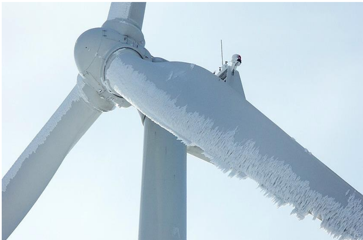
Рис. 1. Пример обледенения лопасти ветрогенератора
