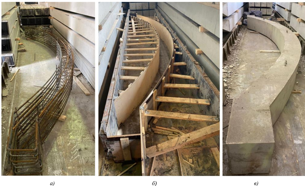
Рис. 3. Визуализация процесса создания железобетонной конструкции: а — арматурный каркас; б — единичная опалубка; в — готовая арочная балка на ребре
