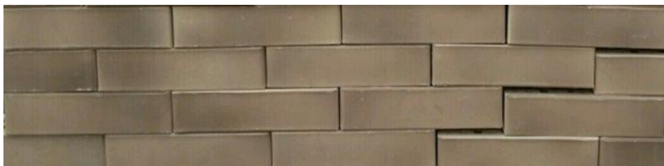
Рис. 8. Декоративная кладка кирпича с применением эффекта деграде (ангобные составы Б-3, К-2, К-4)
