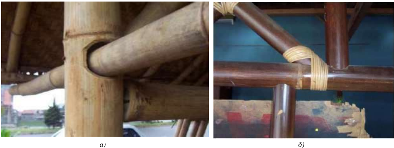
Рис. 1. Примеры соединения бамбуковых стержней: а — сквозное; б — обвязка
